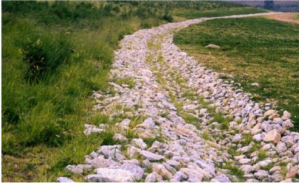
Ilustración 0-15: Circulación del agua a través de un canal revertido de caliza y construido en una escombrera restaurada.
